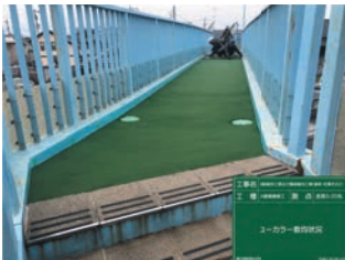
土木工事一式
