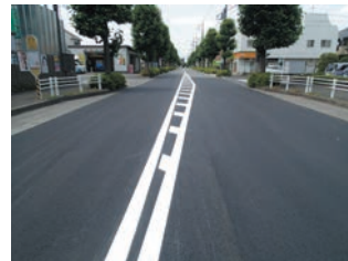
造成・舗装工事
