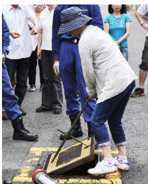
消火栓の蓋開け、足に気を付けて!
